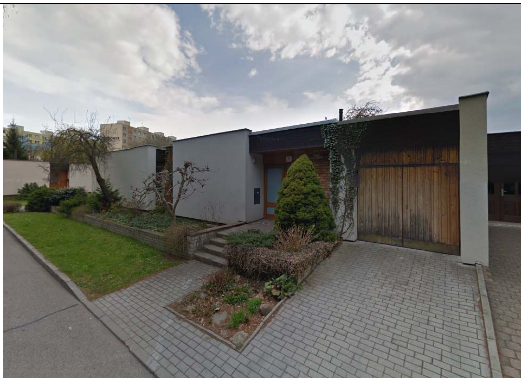
Obrázek č. 3 - popis: Dům manželů Dvořákových od severovýchodu. Autor / Zdroj: - / GSV.
