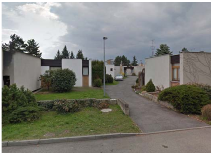
Obrázek č.1 - popis: Vstup do společného dvora
